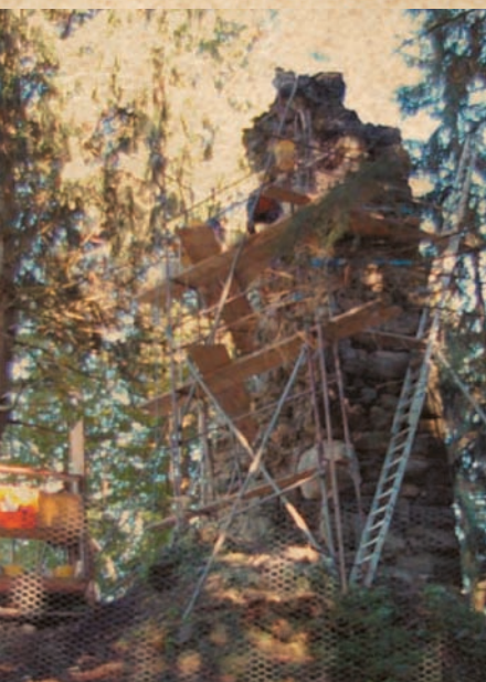
Baustelle Ruine Schwarzhorn
